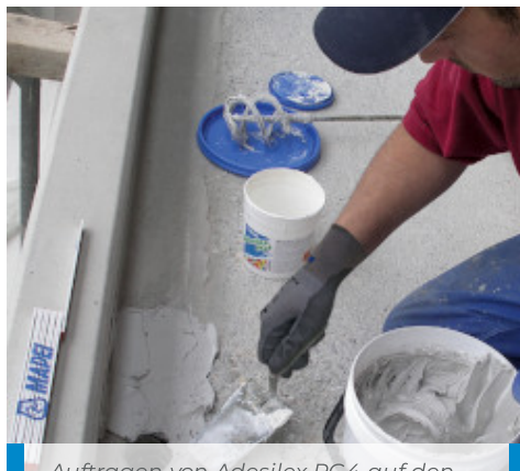
Auftragen von Adesilex PG4 auf den Untergrund
