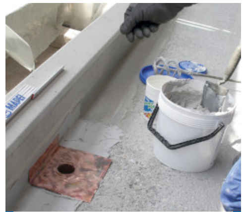
Kleben eines Kupfer-Abflaufs
